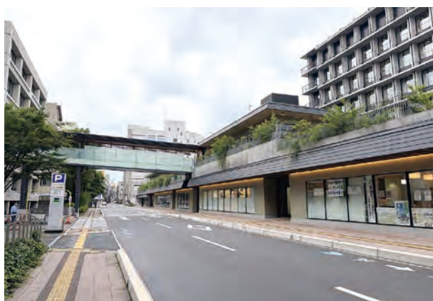
無電柱化が行われた道路（市道荷揚4号線）
