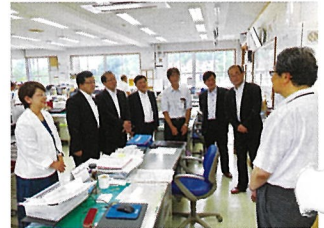
職員室で設備の制御盤の説明を受ける
