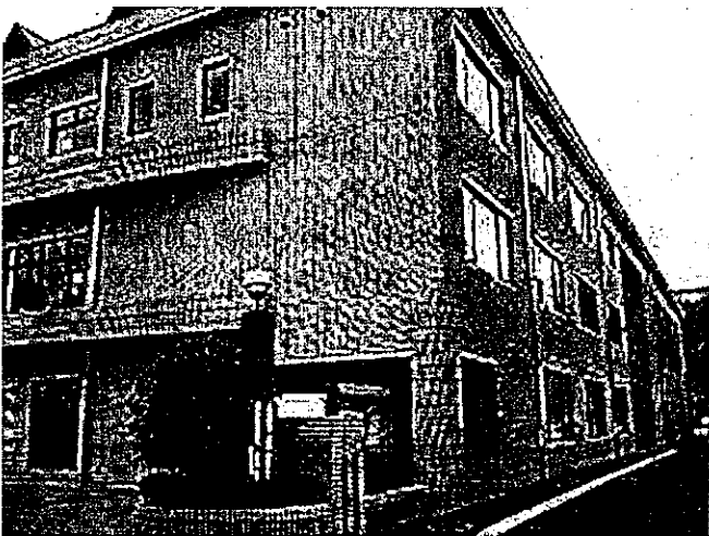
7月の豪雨の際に雨水によって被害を出した西部公民館（被災前）
