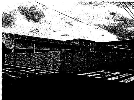
東大分小学校のプール外壁
