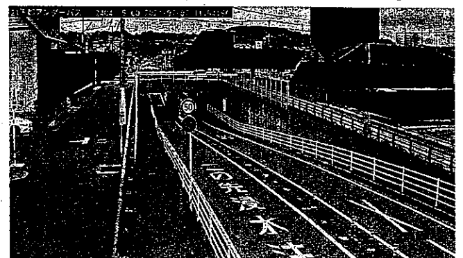
危険なアンダーパス
