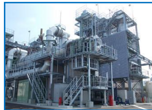
下水汚泥固形燃料化プラント
