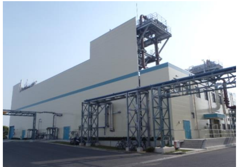
(広島市)西部水資源再生センター (汚泥燃料化施設 50t/日×2基)
