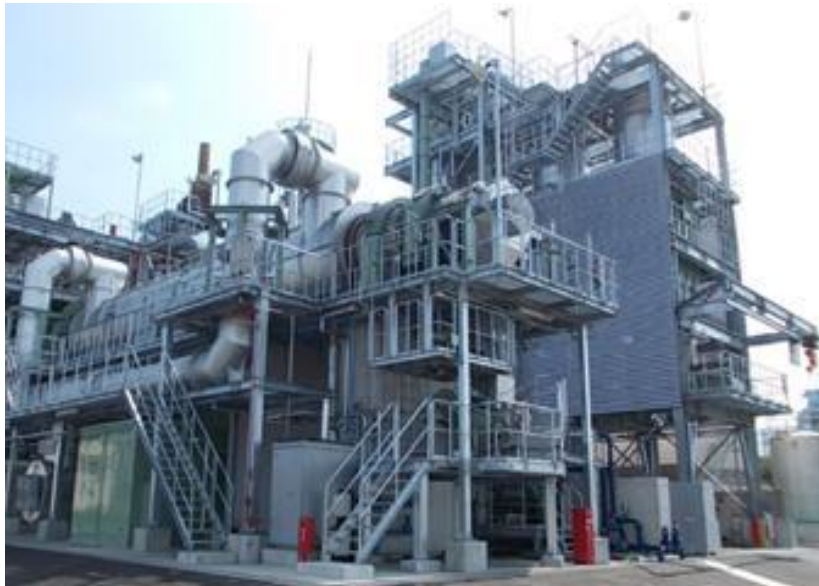
(愛知県)衣浦東部浄化センター (汚泥燃料化施設 100t/日×1基)
