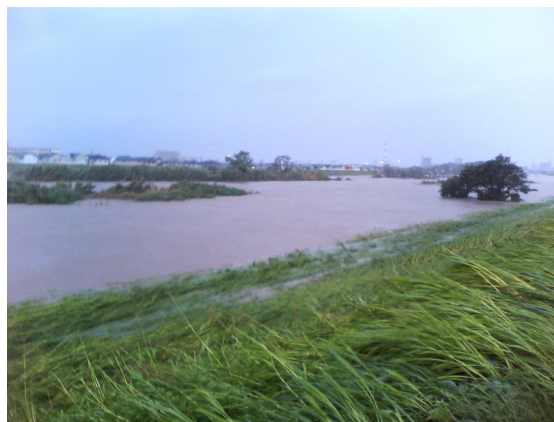
増水した乙津川
