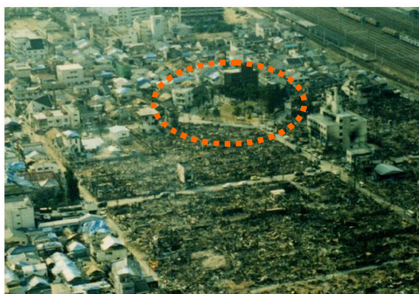
大規模な火災から延焼を防止した公園 (阪神・淡路大震災)(神戸市提供)
