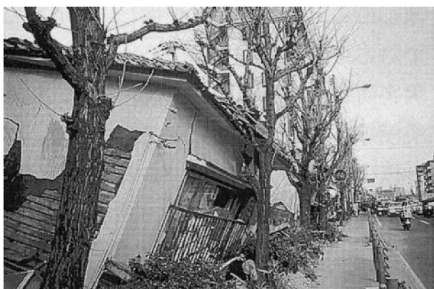
家屋の倒壊を軽減し、避難路を確保した街路樹(阪神・淡路大震災) ( (社)日本公園緑地協会提供)
