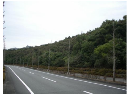
ポット苗による法面緑化 (H20)
