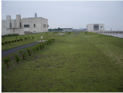
弁天終末処理場の屋上緑化 (H19)
