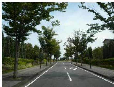
住宅地内の幹線道路 (H20)
