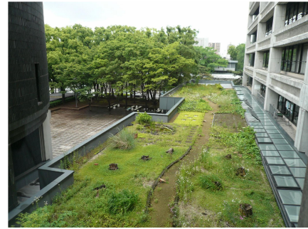
市役所の屋上緑化 (H20)
