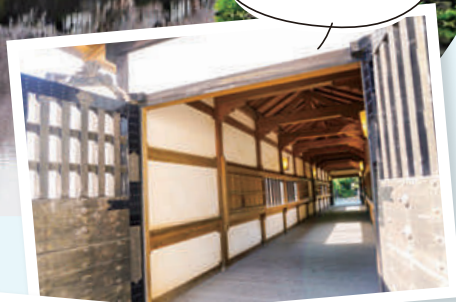
松栄神社へ続く 廊下橋
