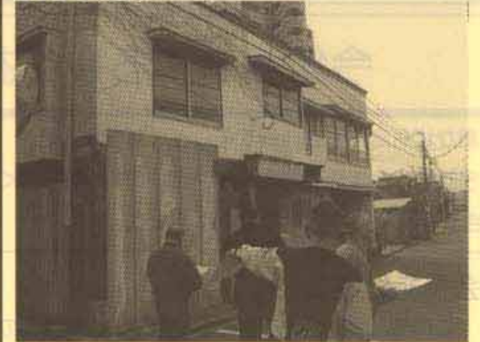
のりを乾燥していた建物
