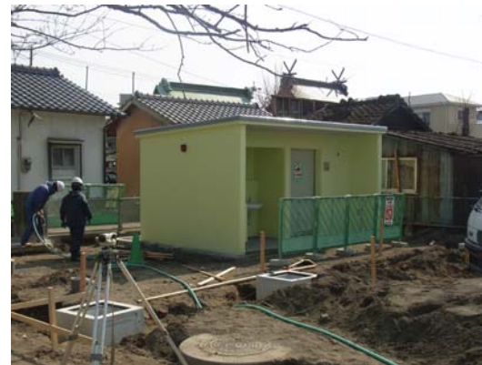
えびす公園で再整備中のトイレ
