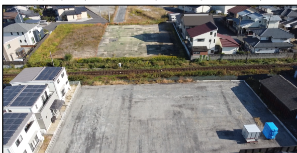
着手前（JR豊肥本線直下部工事箇所）
