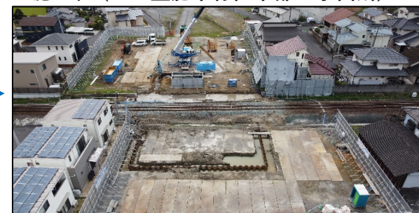
施工中（JR豊肥本線直下部工事箇所）
