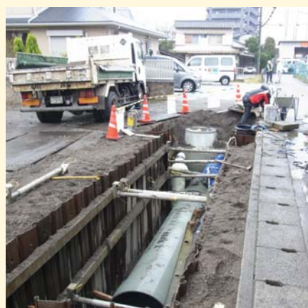
路線Dの工事の様子
