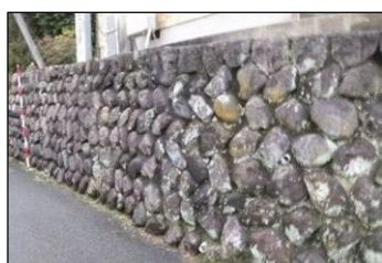
空石積造擁壁
