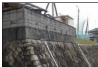
増し積み擁壁
