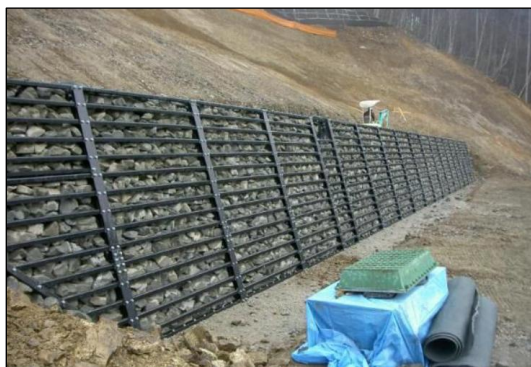
図 2-28 鋼製枠工
