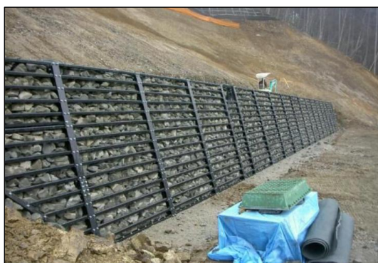
図 2-28 鋼製枠工
