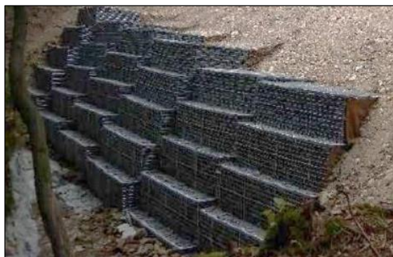
図 2-27 大型かご枠工
