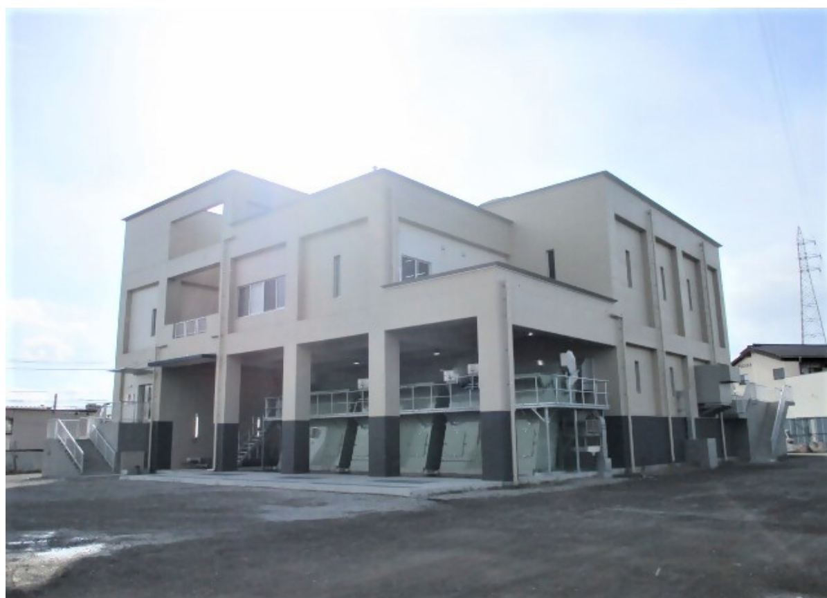
片島雨水排水ポンプ場 新築工事
