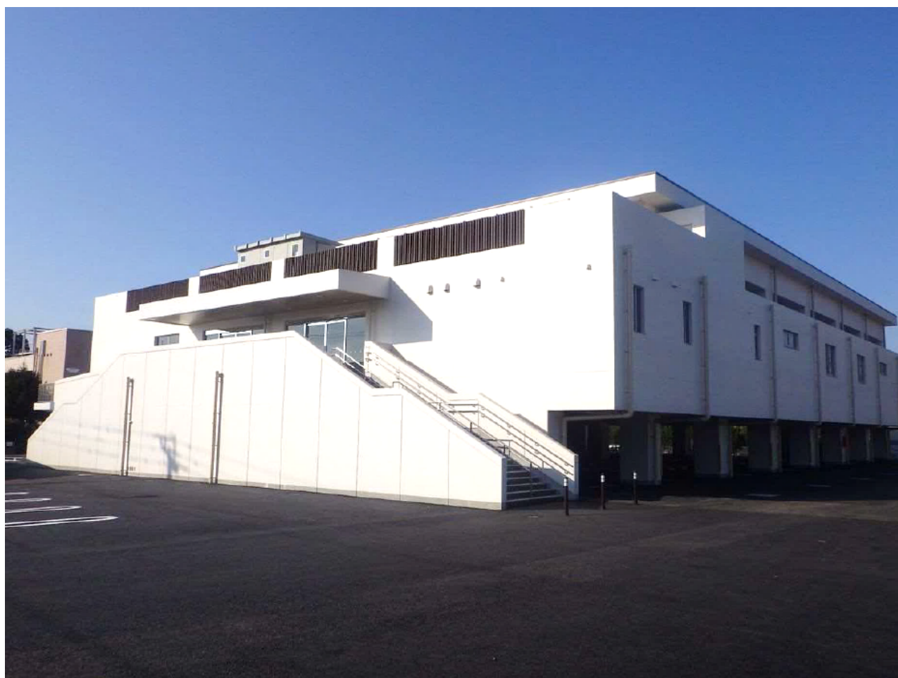
鶴崎公民館集会室棟増築工事(令和5年3月竣工)
