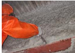
(アスベスト除去の施工事例)
