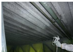
(アスベスト封じ込めの施工事例)
