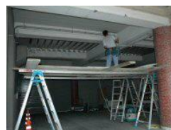
(アスベスト囲い込みの施工事例)
