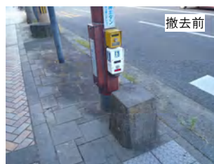
ストリートファニチャーの撤去 （国道197号）
