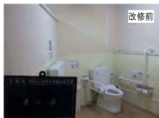
多目的トイレ整備 （鶴崎公民館）
