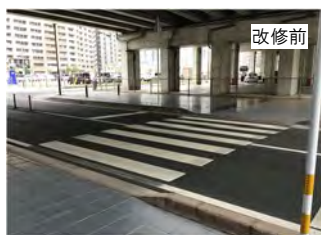
道路の段差解消（市道 金池桜ヶ丘線）
