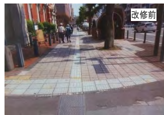
視覚障害者誘導用ブロックの修繕（市道 中央通り線）
