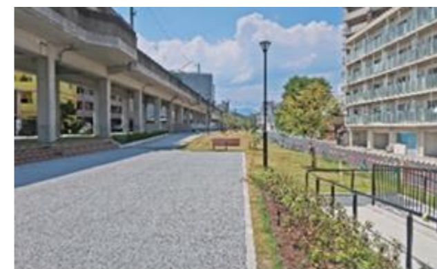
日豊本線西側鉄道残存敷整備事業
