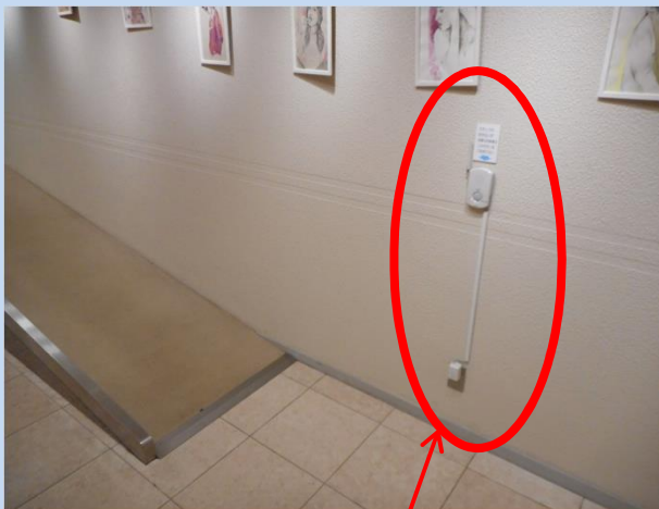
スロープ手前に呼び鈴を設置
