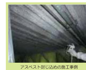
アスベスト封じ込めの施工事例
