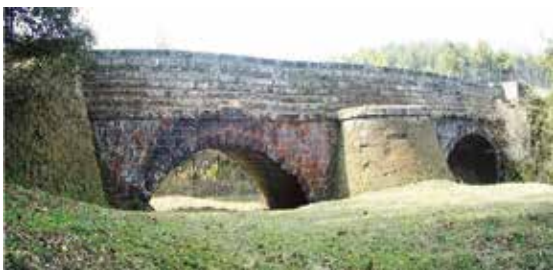
明治大分水路橋
