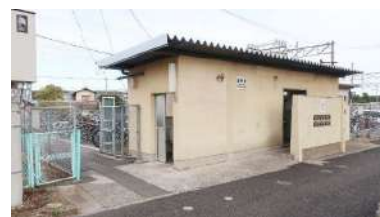
⑮トイレ 古いトイレですが、身障者用のトイレが設置されています。
