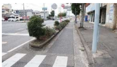
⑩県道 208 号(鶴崎大南線) 西側の一部が自転車道の構造となっています。
