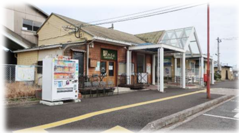
JR 鶴崎駅の駅舎（撮影：2023 年 1 月）
