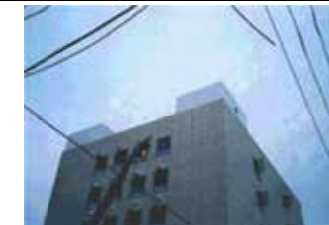
屋上設備に目隠しをしている建物例
