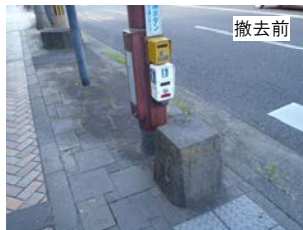
ストリートファニチャーの撤去 （国道197号）
