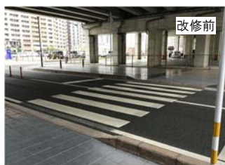
道路の段差解消（市道 金池桜ヶ丘線）
