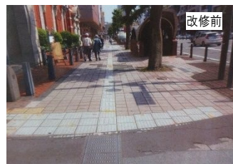
視覚障がい者誘導用ブロックの修繕（市道 中央通り）
