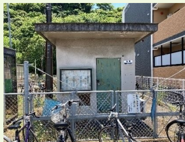
写真⑥(滝尾通信配線室)
