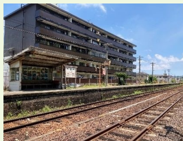
写真③(西側ホーム)
