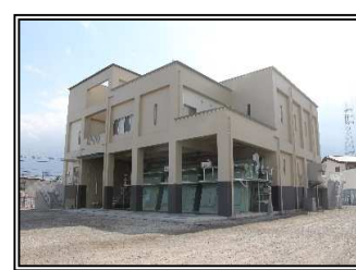
◇片島雨水排水ポンプ場◇
