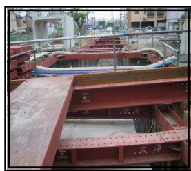
◇雨水管渠布設工事◇
