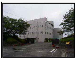
◇弁天水資源再生センター◇
