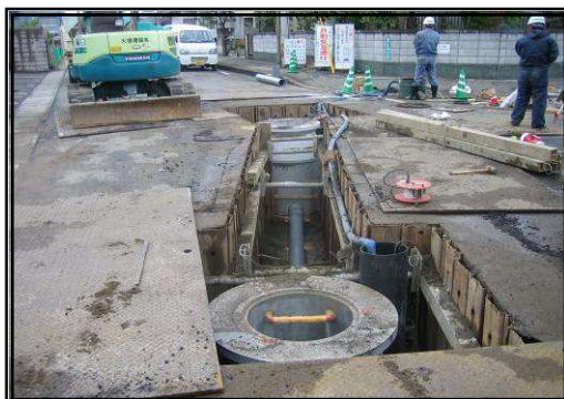
◇汚水管渠布設工事◇
