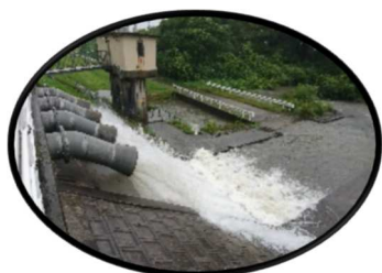
◇浸水被害対応状況◇
