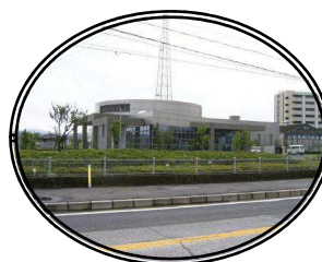
◇南部汚水中継ポンプ場◇
