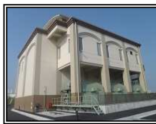
◇皆春雨水排水ポンプ場◇
