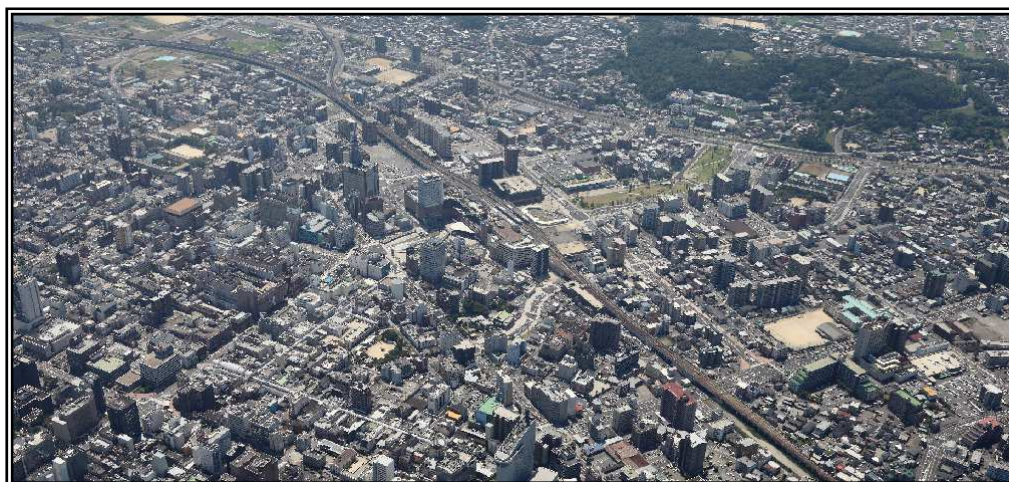
◇連続立体交差事業◇
