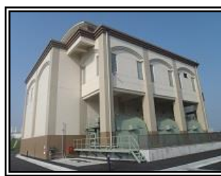
◇皆春雨水排水ポンプ場◇
