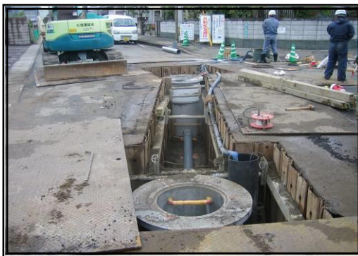
◇汚水管渠布設工事◇
