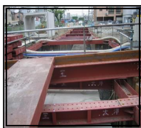
◇雨水管渠布設工事◇
