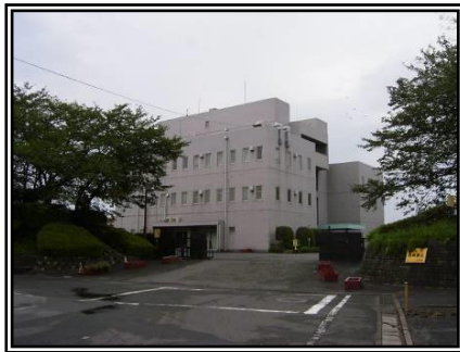
◇弁天水資源再生センター◇
