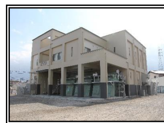
◇片島雨水排水ポンプ場◇
