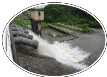
◇浸水被害対応状況◇
