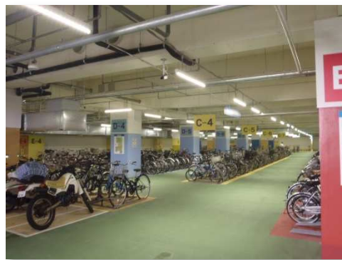
◇大分市中央町地下駐輪場屋内◇
