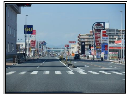
◇国道 10 号宮崎付近◇
