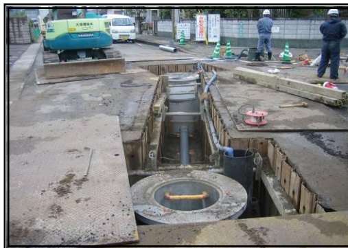
◇汚水管渠布設工事◇
