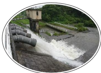
◇浸水被害対応状況◇
