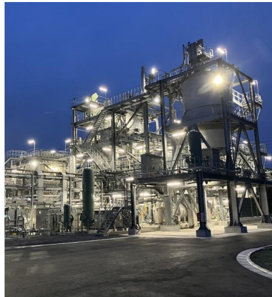
◇下水汚泥燃料化施設◇ ◇（大在水資源再生センター内）◇
