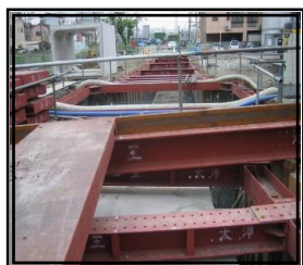
◇雨水管渠布設工事◇
