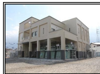
◇片島雨水排水ポンプ場◇
