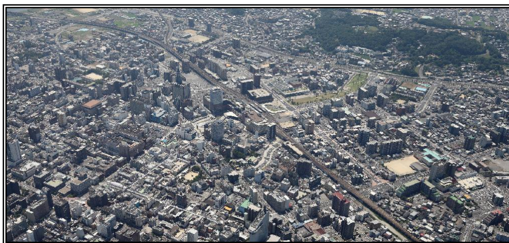
◇連続立体交差事業◇
