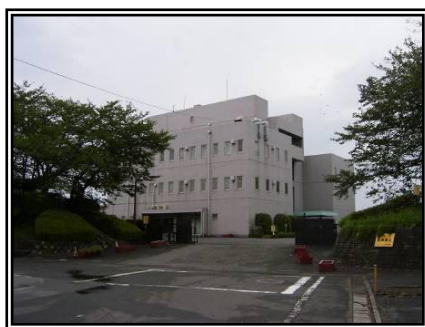
◇弁天水資源再生センター◇
