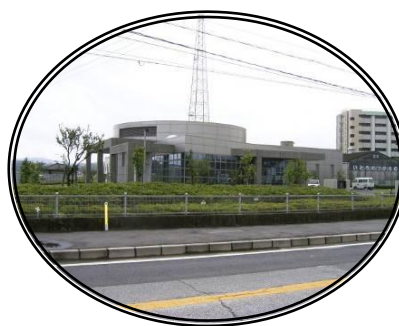
◇南部汚水中継ポンプ場◇
