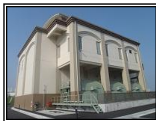
◇皆春雨水排水ポンプ場◇
