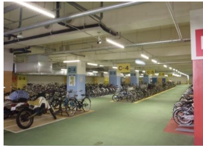
◇大分市中央町地下駐輪場屋内◇
