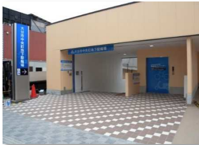
◇大分市中央町地下駐輪場入口◇
