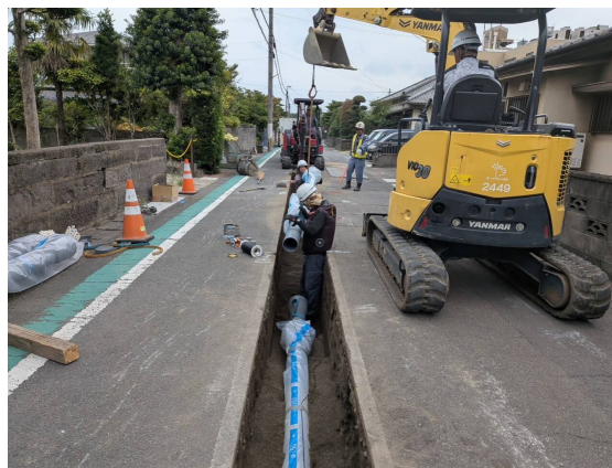
写真3-3-1 上水道の更新イメージ
