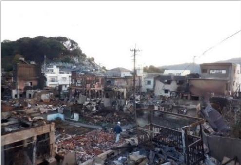
被災直後の被災地の様子
