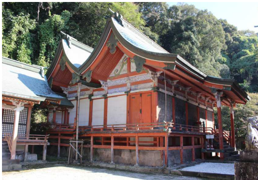
柞原八幡宮 本殿(着工前)
