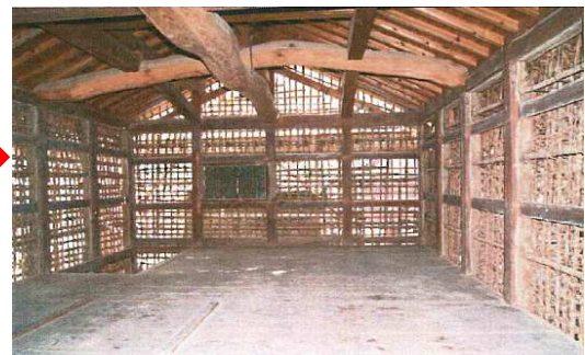
柞原八幡宮 附(つかけたり)・宝蔵(土壁解体)
