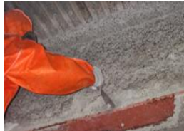
(アスベスト除去の施工事例)
