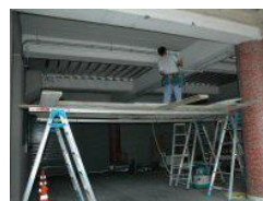
(アスベスト囲い込みの施工事例)
