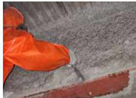
(アスベスト除去の施工事例)
