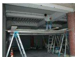
(アスベスト囲い込みの施工事例)
