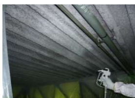
(アスベスト封じ込めの施工事例)
