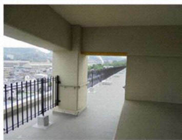
屋上避難スペース
