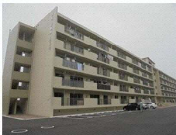
津波避難ビルに指定
