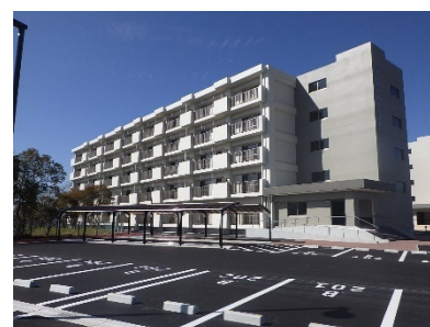
令和3年に完成した市営住宅（数戸南 RI 住宅）▶
