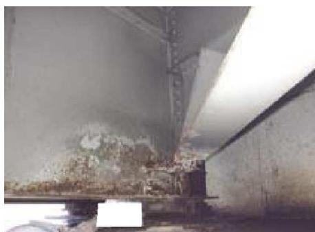
局所的であるが水の進入等により進行が速い位置で確認される主部材の断面減少に至る腐食
