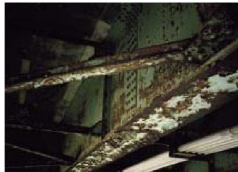
主部材の広範囲で著しい腐食により断面減少が生じている
