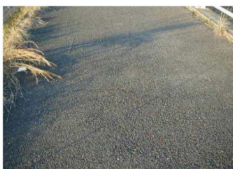
1方向の舗装ひびわれが局部的に確認される
