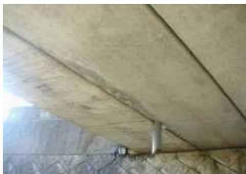
主たる構造部材に局所的な漏水・遊離石灰が確認される。
