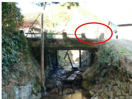
高欄が破断し、歩行者等の転落の恐れがある
