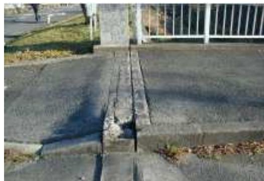
二次部材において安全性を損なわない程度の局所的な変形・欠損が見られる
