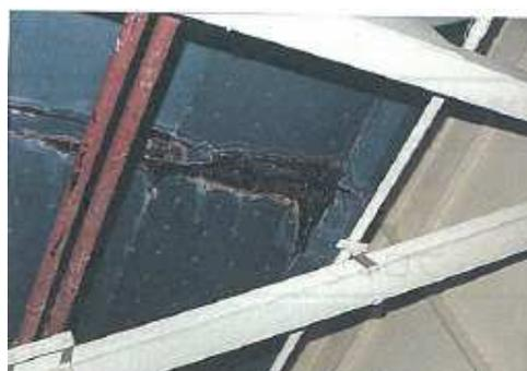
鋼板の断面減少が生じている
