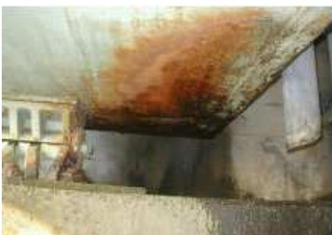
主部材で生じた局所的な表面錆程度の腐食であるが、水の侵入等により進行が速い位置で確認される
