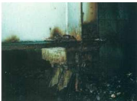
支承本体が著しく腐食し、可動機能や回転機能が著しく損なわれている
