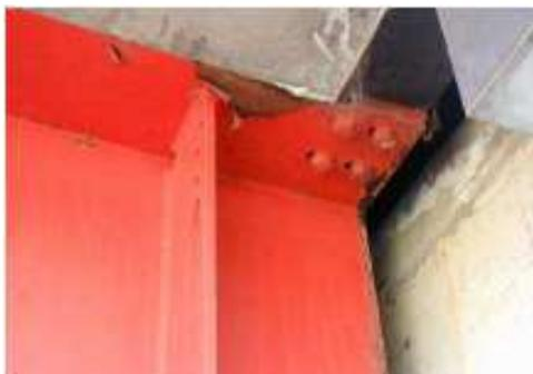
局所的に生じた表面錆程度の腐食や塗装劣化
