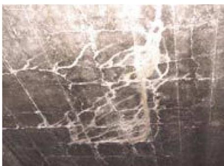
漏水・遊離石灰や錆汁を伴う 0.2mm 以上を主とした間隔の狭い2方向ひびわれ
