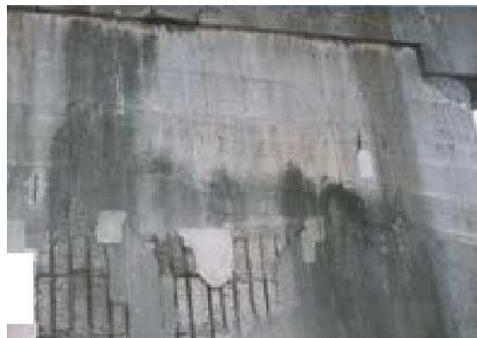
主たる構造部材の広範囲で鉄筋が露出している
