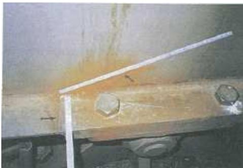
主桁下フランジから腹板まで達した亀裂
