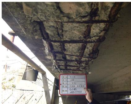
主鉄筋の減肉を伴う部材広範囲に亘る剥離・鉄筋露出
