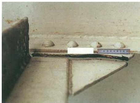
対傾構の破断
