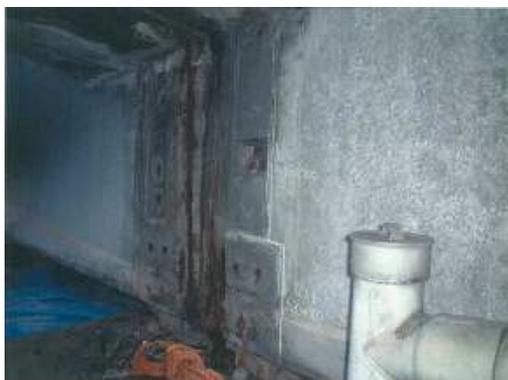
横締めが露出し、定着部の腐食が生じている
