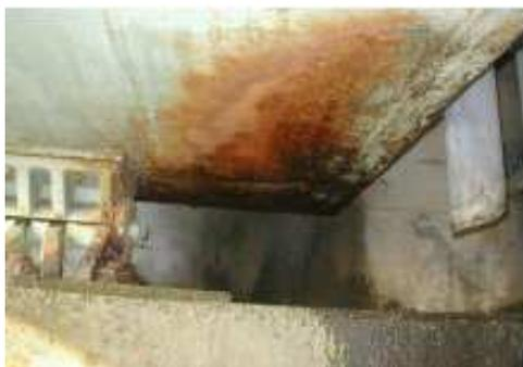
主部材で生で局部的に水の侵入等により進行が速い位置で確認される塗膜の劣化
