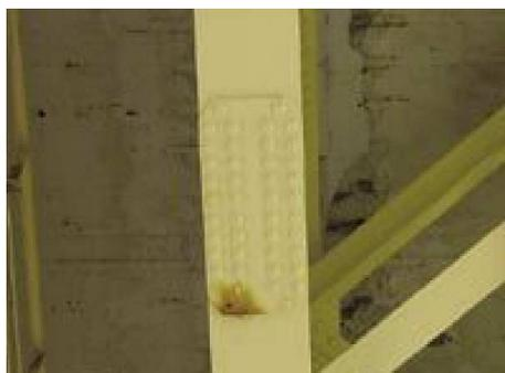
主桁の添接ボルトで少数の脱落（第三者被害無し）
