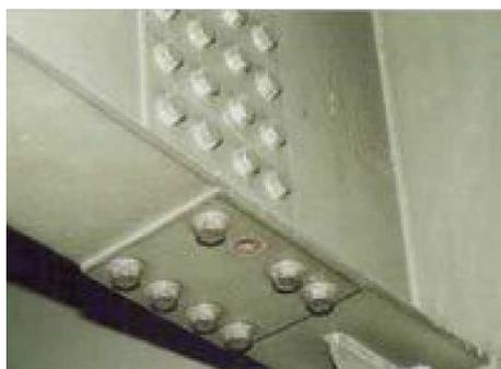
桁下が鉄道・道路など第三者被害の恐れがある箇所における F11T ボルトの脱落
