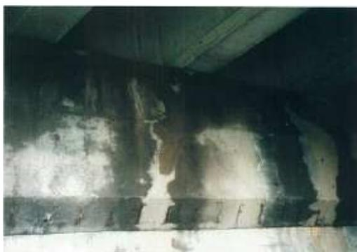
伸縮装置の防水機能低下による漏水が見られるが主部材等の損傷には繋がっていない
