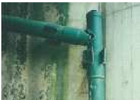
プラスチックが劣化により破損
