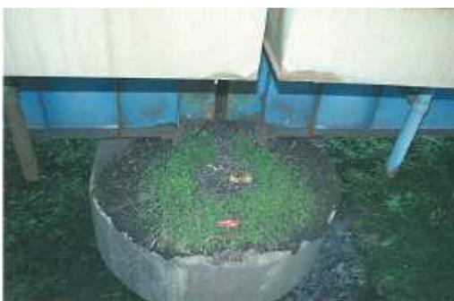
沓座に土砂が堆積している
