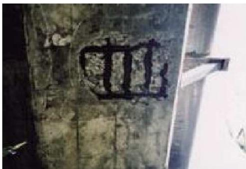
主たる構造部材で、鉄筋が露出しており、主鉄筋の断面減少を伴う腐食が生じている
