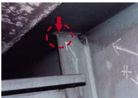
垂直補剛材と上フランジの溶接部に生じた亀裂又は塗膜割れ
