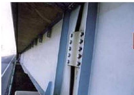
鋼主桁に変形が生じている
