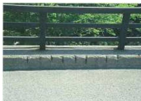
地覆等の二次部材において剥離・鉄筋露出が散見される
