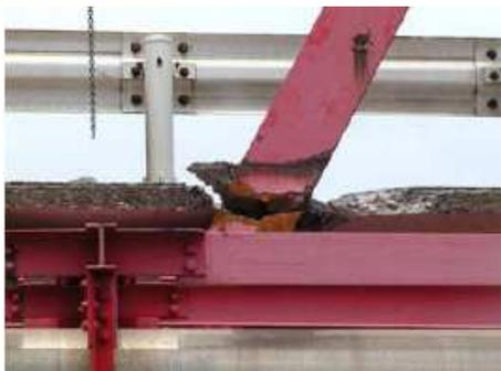
トラス橋の斜材の破断
