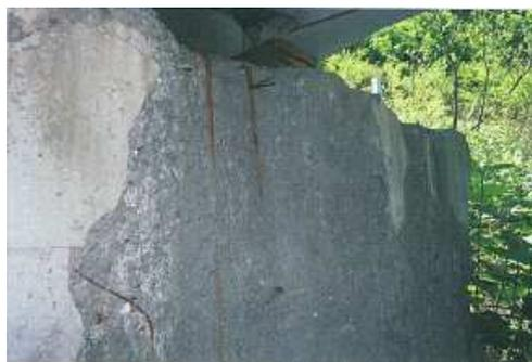
凍害の恐れのある断面欠損
