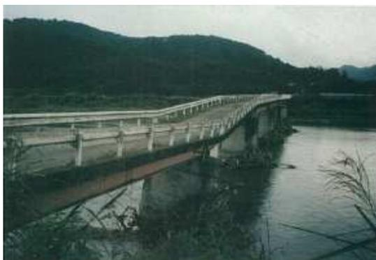
橋脚に沈下が生じている
