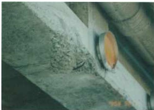
車両衝突により生じた軽微な断面欠損が生じている
