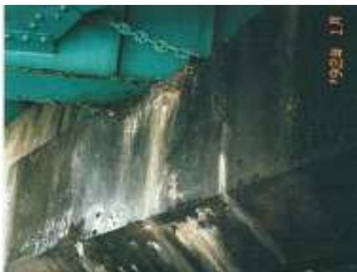
伸縮装置の防水機能低下により鋼桁等の腐食に繋がる著しい漏水が見られる
