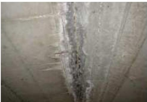
錆汁は見られないが主たる構造部材の広範囲で漏水・遊離石灰が確認される。
