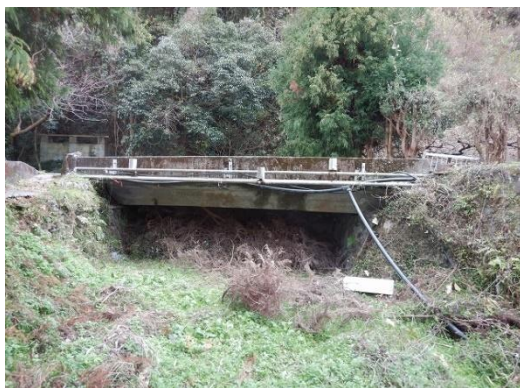
▲河川改良に伴う構造変更（橋梁撤去）
