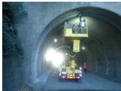
【 トンネル点検 】
