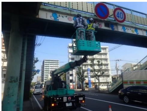
【 横断歩道橋点検 】
