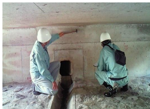
【 橋梁点検（職員） 】
