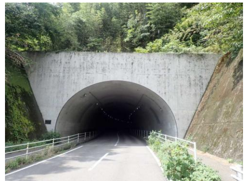
【NATM工法トンネル（1992年竣工）】
