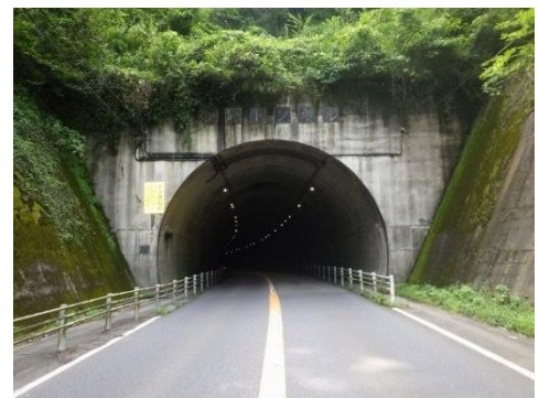
【矢板工法トンネル（1986年竣工）】
