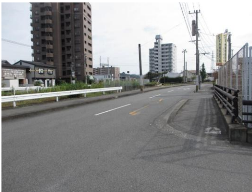
▲施設上部（市道）
