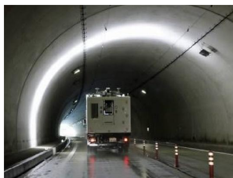
▲走行型トンネル点検システム
