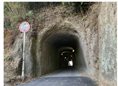
【無巻(素掘り)トンネル（竣工不明）】
