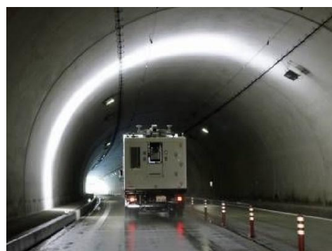
▲走行型トンネル点検システム
