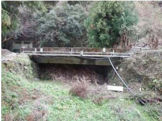
▲河川改良に伴う構造変更（橋梁撤去）
