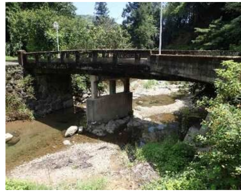
▲利用環境の変化に伴う橋梁撤去
