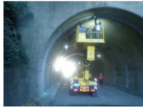
【 トンネル点検 】
