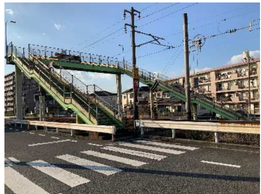
【鋼・鋸桁橋（跨線橋）】
