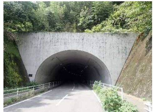
【NATM工法トンネル（1992年竣工）】
