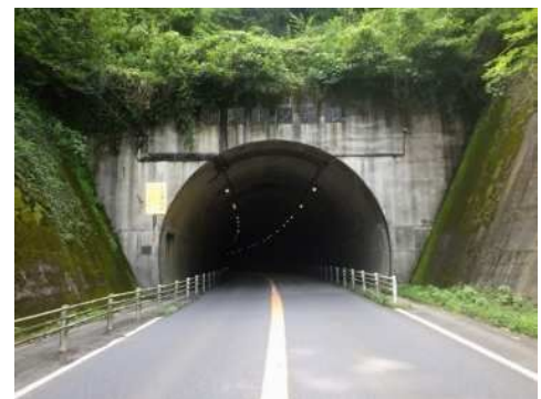
【矢板工法トンネル（1986年竣工）】
