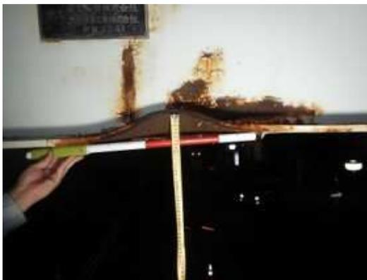
【 主桁の変形(車両接触)・腐食】
