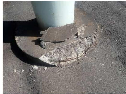
【 橋脚基部のうき・剥離・鉄筋露出】
