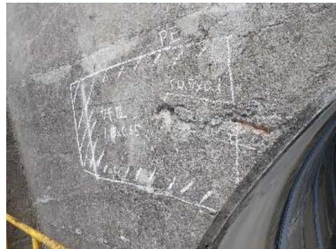
【坑門工のうき・鉄筋腐食】
