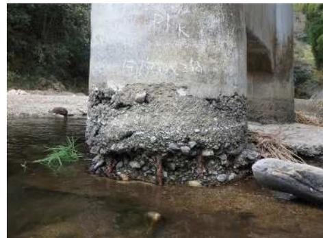
【 橋脚柱基部の剥離・鉄筋露出 】
