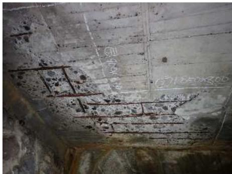
【 床版の剥離・鉄筋露出 】
