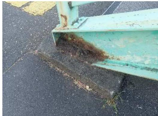
【 階段部基礎の腐食】
