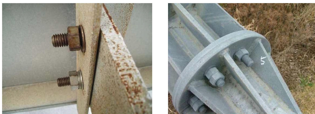
写真-解 8-10 設置後 10 年以内の附属物の変状事例
