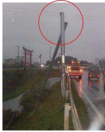
写真-解 8-8 支柱継手部の折損状況
