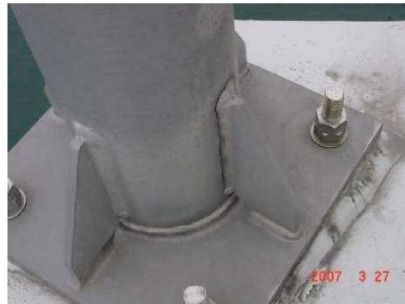
標識柱基部溶接部の亀裂
