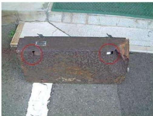
落下照明背面状況
