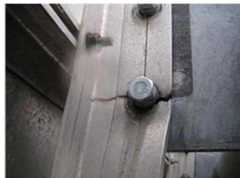
取付部の変状状況
