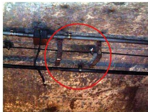
落下照明取付部の状況
