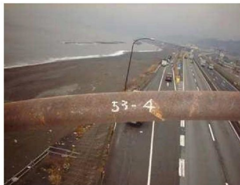
写真-解 8-11 支柱本体の腐食事例
