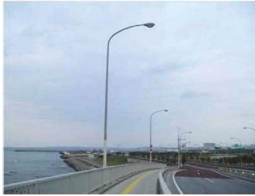
海岸付近に設置
